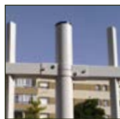
Detall brida per tub rodó de \varnothing 60 mm.
